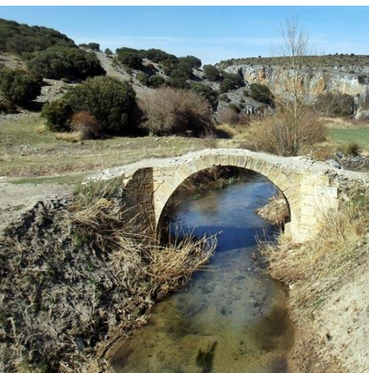
Puente de San Felices sobre el río Añamaza.
