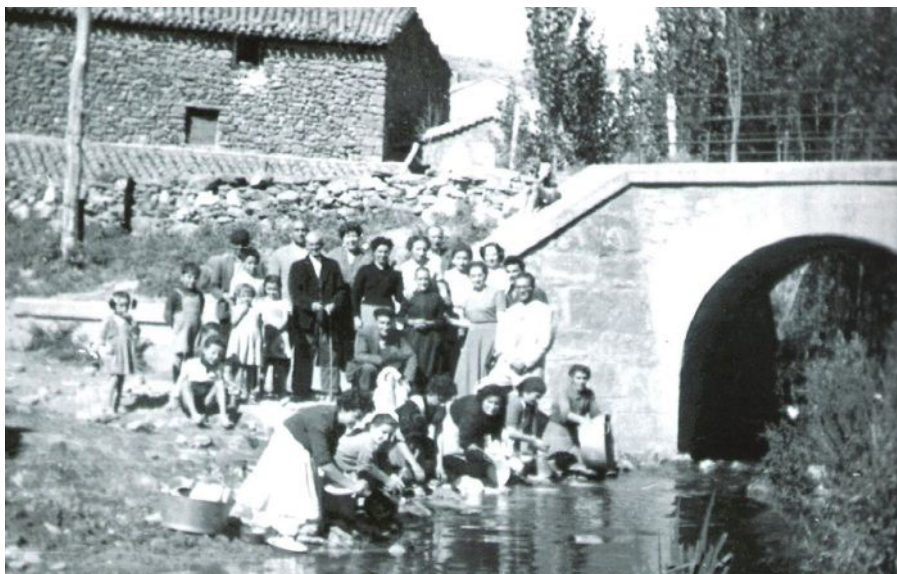
Dévanos. Lavadero público situado entonces a pie del puente que da entrada al pueblo.
